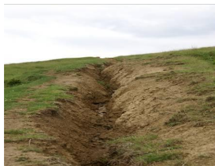
Photo 6. Erosion torrentielle (sillon) - Bâta Goală.
